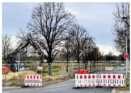
An der entwidmeten Cousteaustraße wird ein neues Baufeld freigeräumt. Foto: Link
